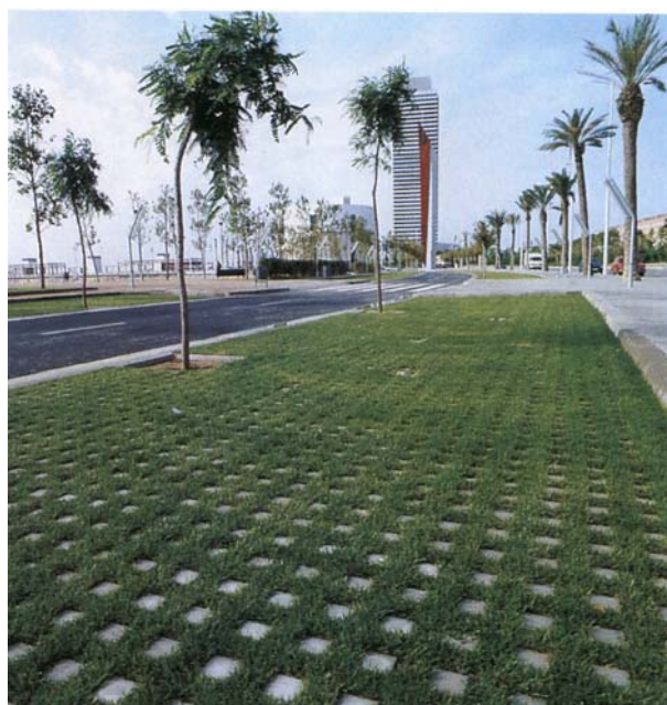
Figura Nº 1.7: Ejemplo de técnica de infiltración (Barcelona).
