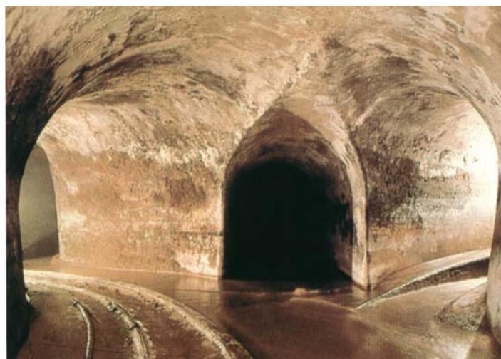
Figura N° 1.5: Confluencia de conducciones "visitables" (Barcelona, España).
