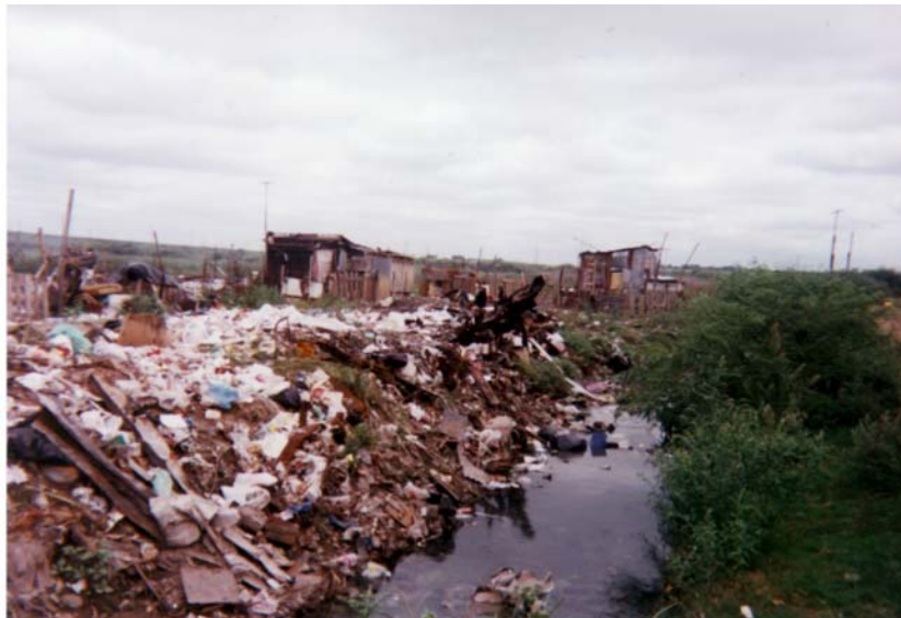
Figura Nº 1.3: Canal de desagüe parcialmente obstruido por basura.
